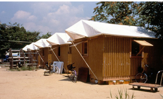
Shigeru Ban, Abris en tubes de cartons suite au tremblement de terre au Japon à Kobé en 1995
